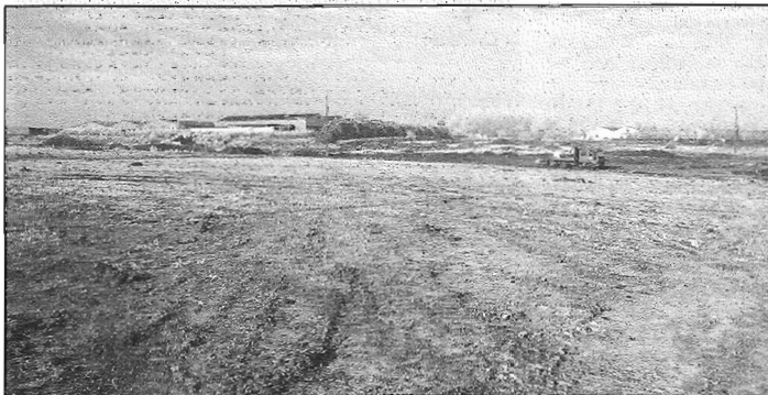
Les travaux pour l'installation du premier investisseur devraient commencer à l'automne.
