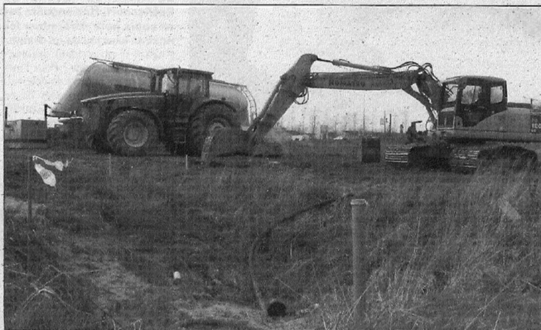
Les derniers travaux d'aménagement sont en cour sur le parc de Tincques.
