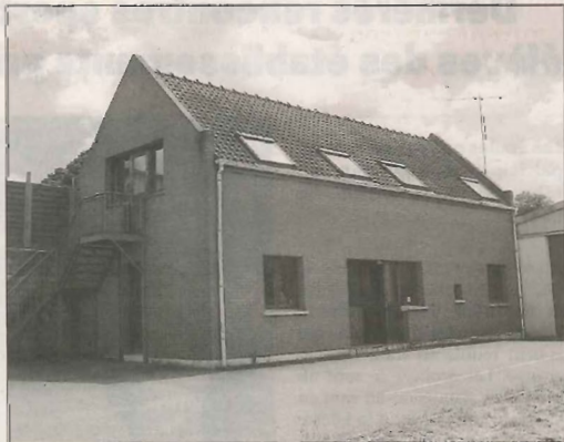
Trois ans après le départ des sapeurs-pompiers, le bâtiment de l'ancien SIVOM va connaître une nouvelle vie.
