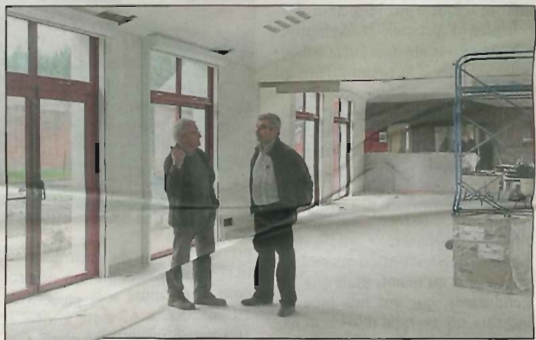
Le chantier d'aménagement de la salle d'animation est en cours de finition
