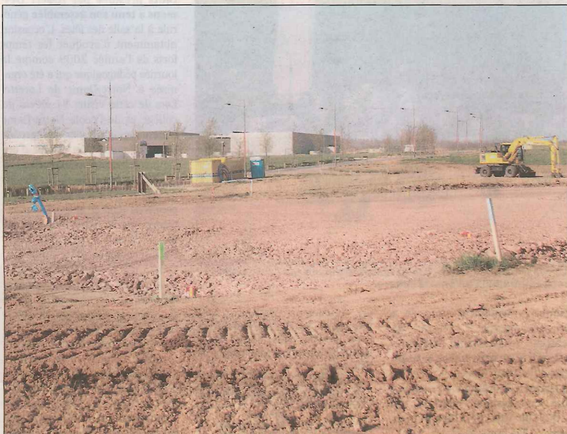
Le chantier de la plateforme multi-services vient de s'ouvrir sur le parc de Tincques.
