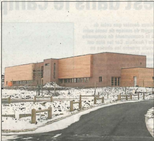
La fin des travaux de la plateforme multiservices est annoncée pour le 13 janvier.
