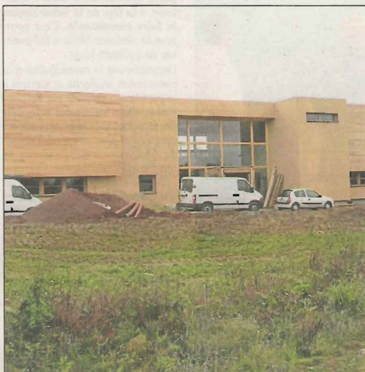
La plateforme multiservices du parc Écopolis, en cours de réalisation, représente un investissement de 2,3 millions d'euros.
