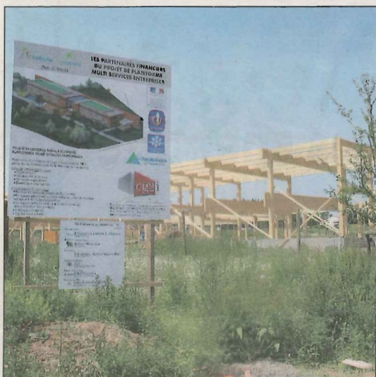
La construction de la plateforme multiservices est actuellement en cours sur le parc de Tincques, visible par son ossature en bois.
