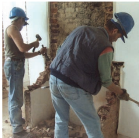
Le chantier école, au presbytère d'Avesnes-le-Comte
